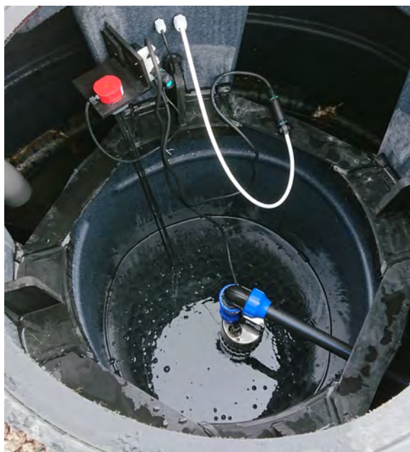
Bild 8. Vattenpumpens placering i ProACT®.
