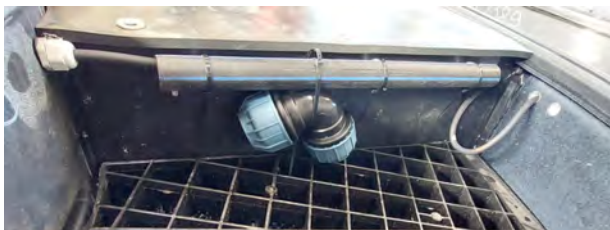
Bild 6: Kabeldragning för luftpumpen och värmekabeln ska ske genom förmonterad PEM-slang.
